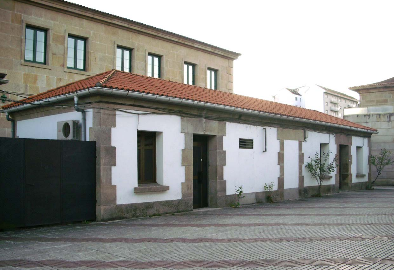
Vistas dos antigos retretes da estación Ourense-Empalme, actualmente reconvertido en cuartos de interventores (2008).
