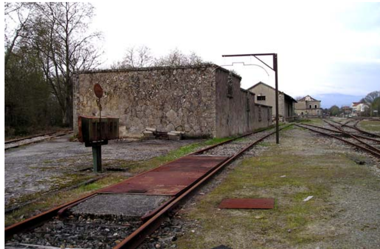
Esquema de instalaciones y vías de la estación de O Irijo. Con la distribución aplicada a las estaciones del Directo. Se observan los dos andenes, el muelle de mercancías y a su izquierda el cargadero de ganado. Las viviendas de ferroviarios están situadas a la derecha del edificio de viajeros. Contaba también con cinco grúas hidráulicas y un inusual puente giratorio de 25 metros.
