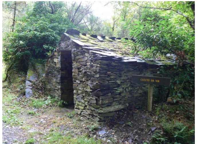
Foto superior: Fachada de la estación de Ribadeo en estado original. Foto izquierda: Estación de Villaadrid a principios del siglo XX (Vía Libre, Julio-Agosto 2004). Foto derecha: Estación de Ribadeo en 1920 Foto inferior: "Caseto" para abastecimiento de carbón a las locomotoras.
