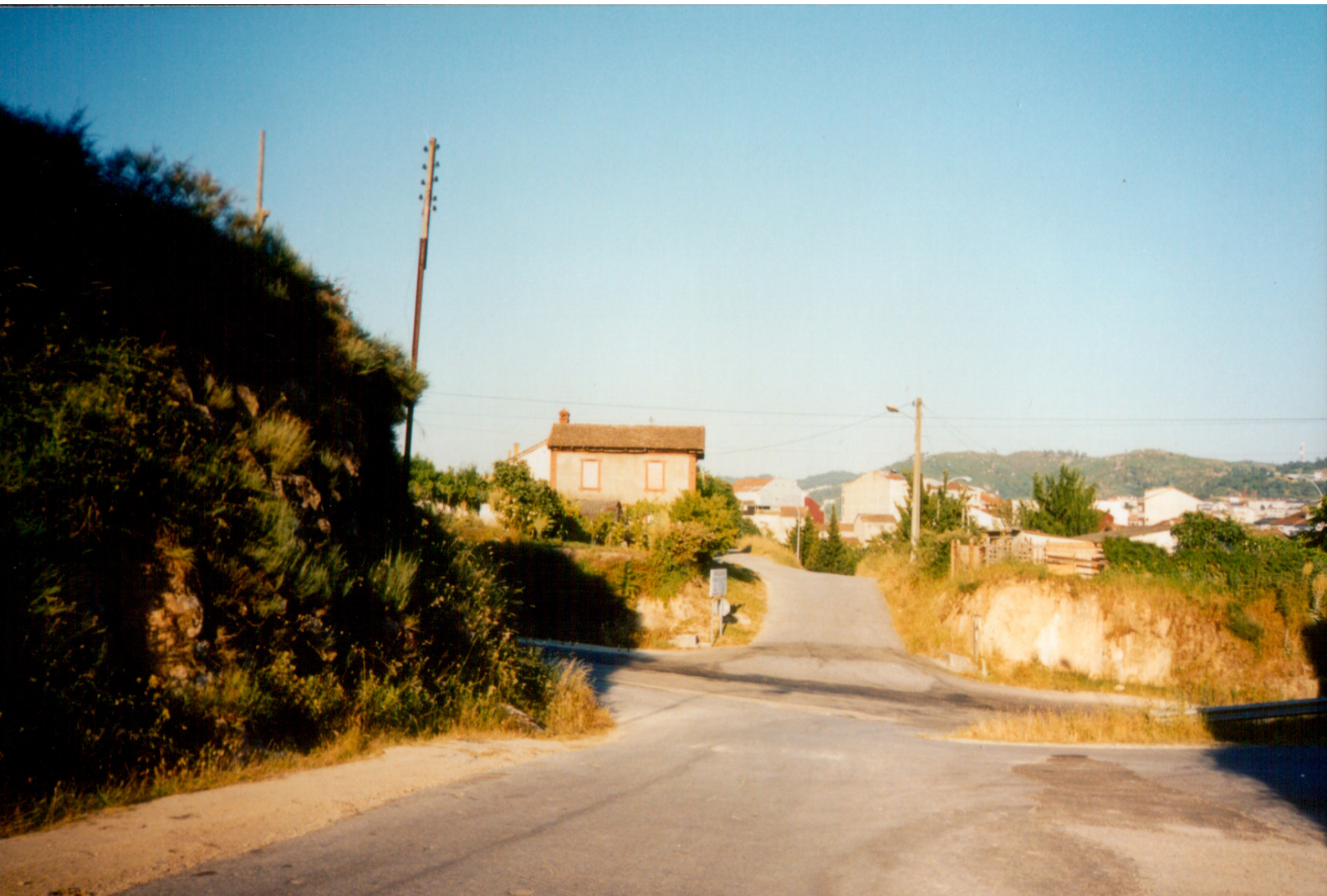
Imagen inferior: Casilla de Canedo, con los restos del antiguo trazado del ferrocarril de Ourense a Vigo a la salida de la estación de Ourense-Canedo. Esta casilla estuvo habitada hasta 2005.
