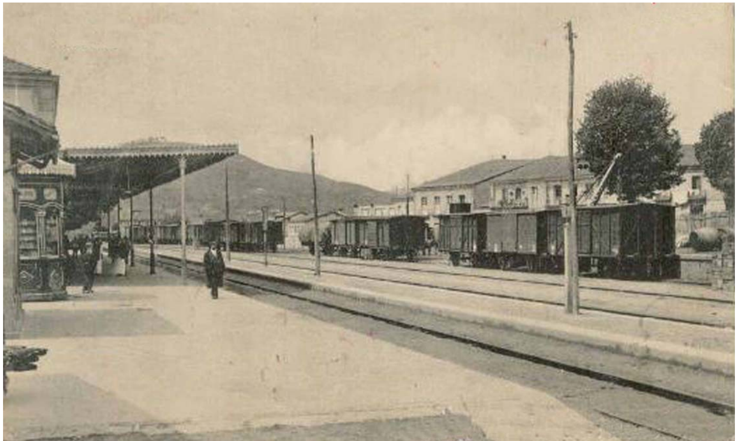
Imagen sup. izq: Rápido Vigo-Coruña, destino Irún, en Os Peares, año 2009. Imagen sup. dch: "Vagoneta del Mondragón" con el equipo de mantenimiento de la electrificación del ramal en los años 90 Imagen inferior: Vagones de mercancías estacionados en Ourense-Canedo a finales del siglo XIX..
