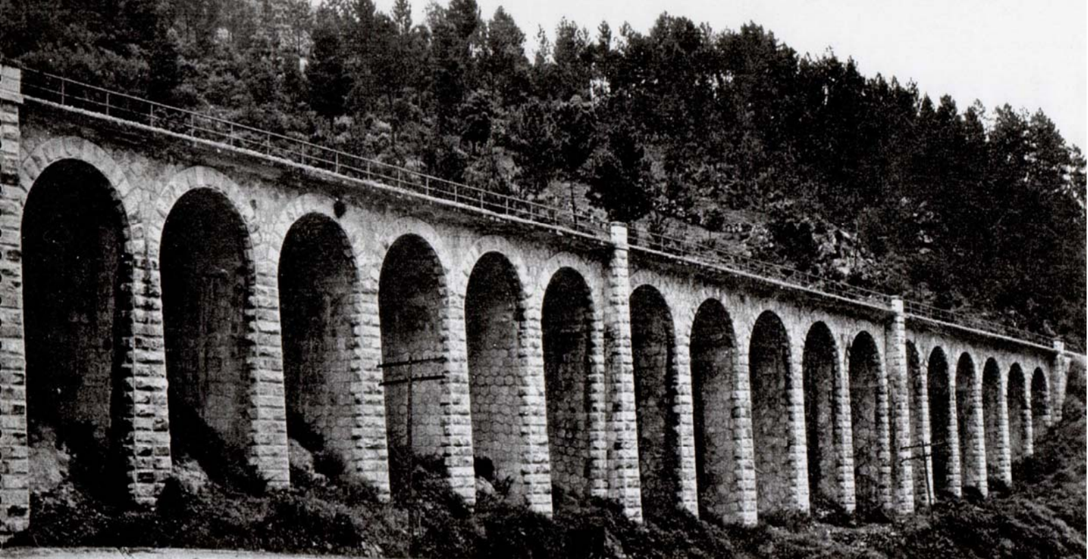
El viaducto Sixtis es la otra gran obra ferroviaria con que cuenta el Ayuntamiento de Ourense
