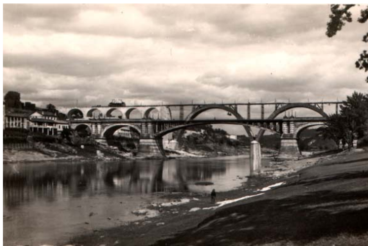
Dos vistas de las distintas fases de construcción del viaducto
