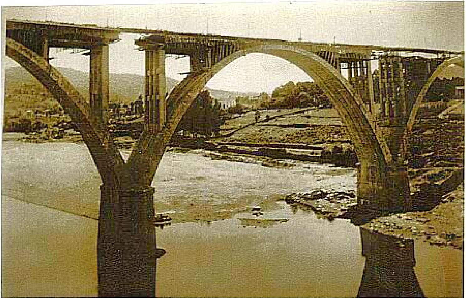
última fase constructiva del viaducto, donde ya se están construyendo los apoyos para el tablero y el remate de los arcos de los tímpanos aligerados.
