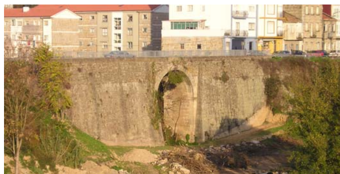
Puente del Ribeiriño (1881-1885) tiene el honor de ser la infraestructura ferroviaria mas antigua que conserva Ourense
