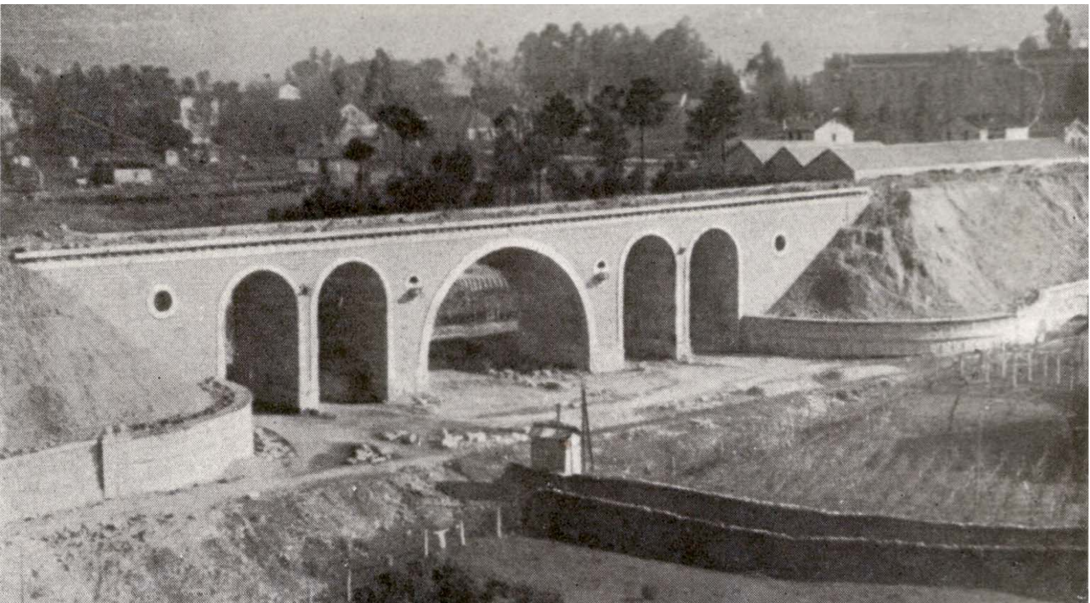
Vista del puente de As Lagoas a punto de ser finalizado.
