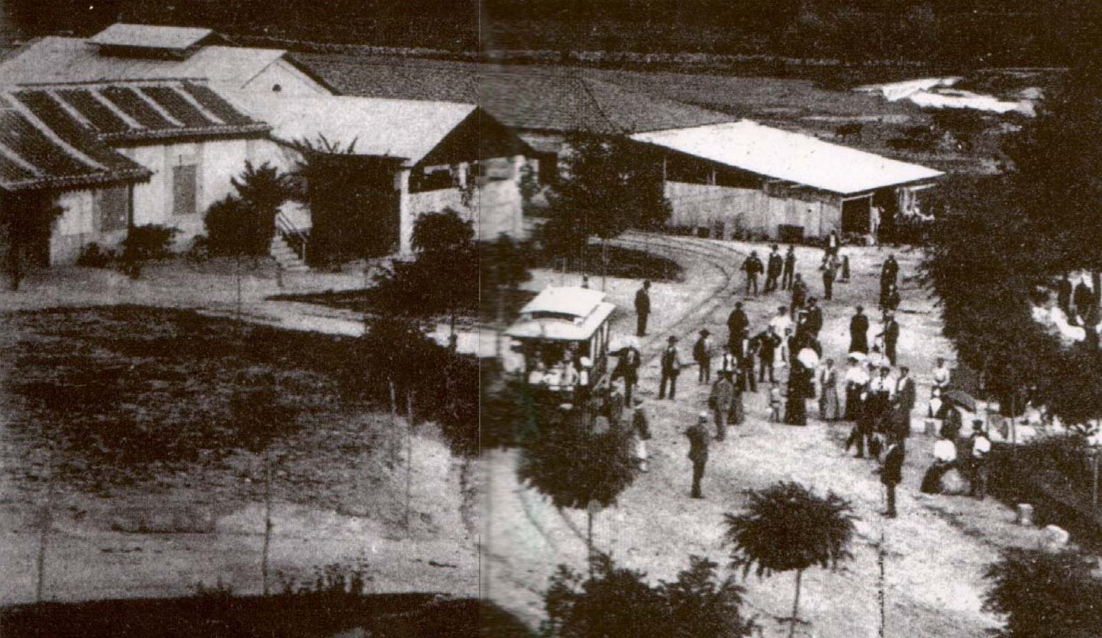
Imagen superior: Vista de parte del parque, correspondiente a la zona de los almacenes de agua embotellada y de las cocheras de los tranvías. En primer término vemos uno de ellos. Un poco más al fondo se puede observar el desvío y las dos vías que se dirigen a lo que suponemos son las cocheras (el edificio con lucernario, de factura típicamente ferroviaria). En segundo plano se pueden ver los almacenes antes mencionados que se comunicaban mediante una vía de 50 cm. con la zona de embotellado.
