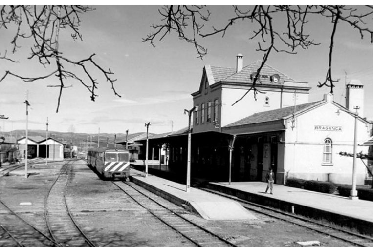
Estación de Bragança, final de la línea en 1987.
