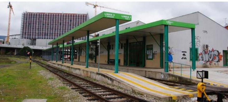
Estación de Mirandela-Plaget, en 2010.
