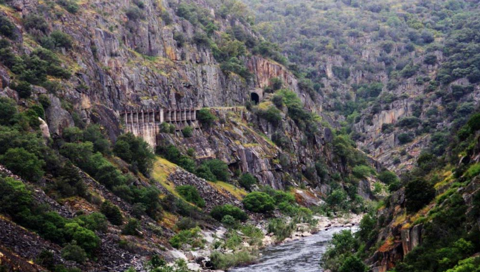
Viaducto y túnel de Fragas Mas, entre las estaciones de Catanheiro y Stª Luzia.
