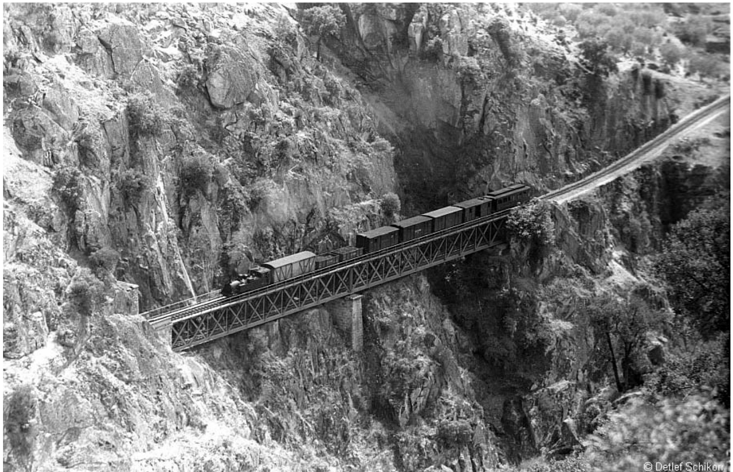
Viaducto das Presas (foto Detlef Schikorr).
