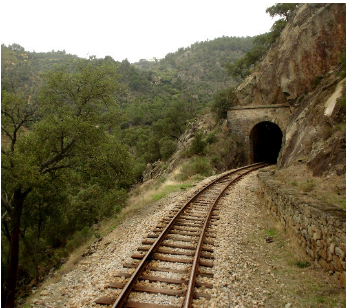
Túnel de Tralhariz de 45m en curva, en 2006 (foto Daniel Conde).
