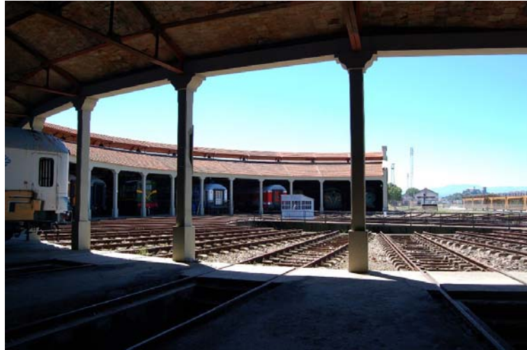
Imagen actual de la rotonda que acoge parte de las instalaciones de Museo do Ferrocarril de Galicia.
