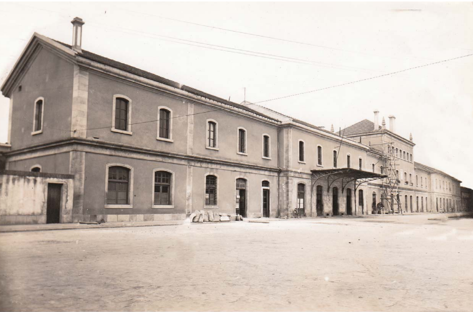
Abajo: Edificio de viajeros aún en obras de ampliación, en 1956
