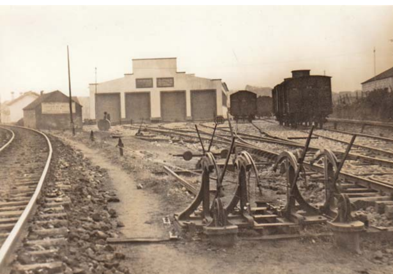
Arriba: Vías de entrada al nuevo depósito, con un desvío triple. 1955
