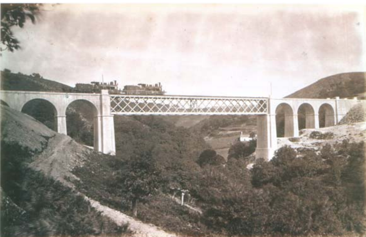
Imagen inferior: Viaducto sobre el río Liñares, entre Monforte y Oural, con dos locomotoras haciendo las pruebas de carga. 1883
