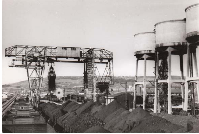
Imagen del puente grúa y depósitos de agua del depósito monfortino, 1954
