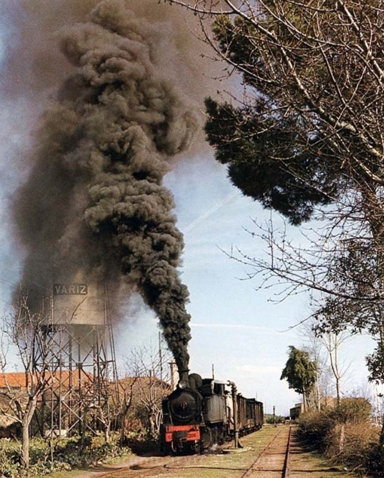
Imagen superior: Tren mercante con una E200 avituallándose de agua en la estación de Variz, pk 78.0, en los años 70
