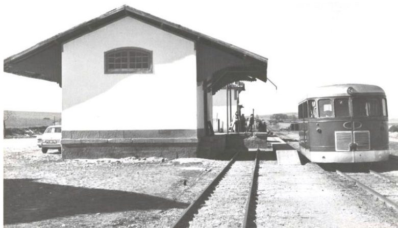
Otra vista del apeadero de Sendim desde el muelle de mercancías
