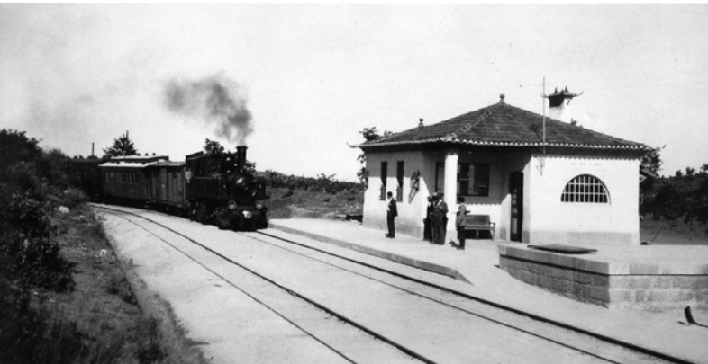
Apeadero de Vilar de Rei, Pk 68,8
