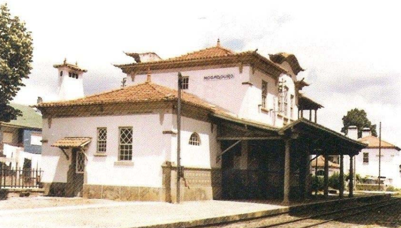
Estación de Mogadouro, Pk 72,5
