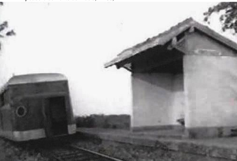
Apeadero de Fonte de Aldeia, Pk 99,7
