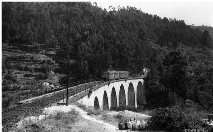
Imagen superior: Unidad doble UD en 1973 atravesando un puente de la línea. Foto Detlef Schicorr.
