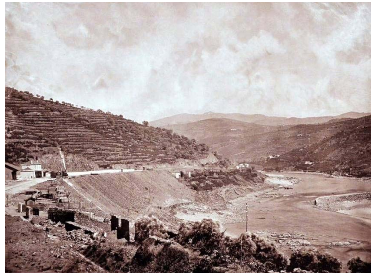
Imagen superior: Construcción de la Línea del Duero a finales del siglo XIX, en la estación de Caldas de Moledo
