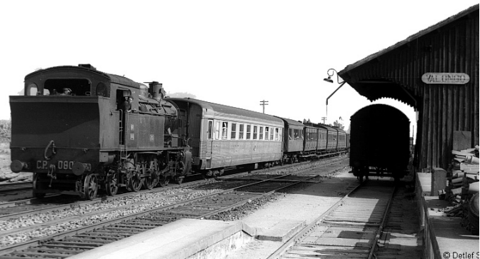
Imagen superior: Locomotora CP serie 080, tipo 1-3-2 en la estación de Valongo. Foto Detlef Schicorr.
