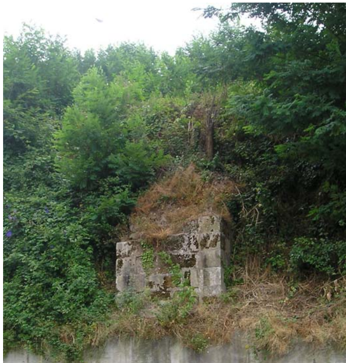
Estado actual. La trinchera ha sido todavía más rebajada para posibilitar la prolongación de la calle de Serafín Avendaño.
