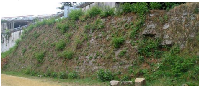
Muro de contención aprovechado para la AP-9.
