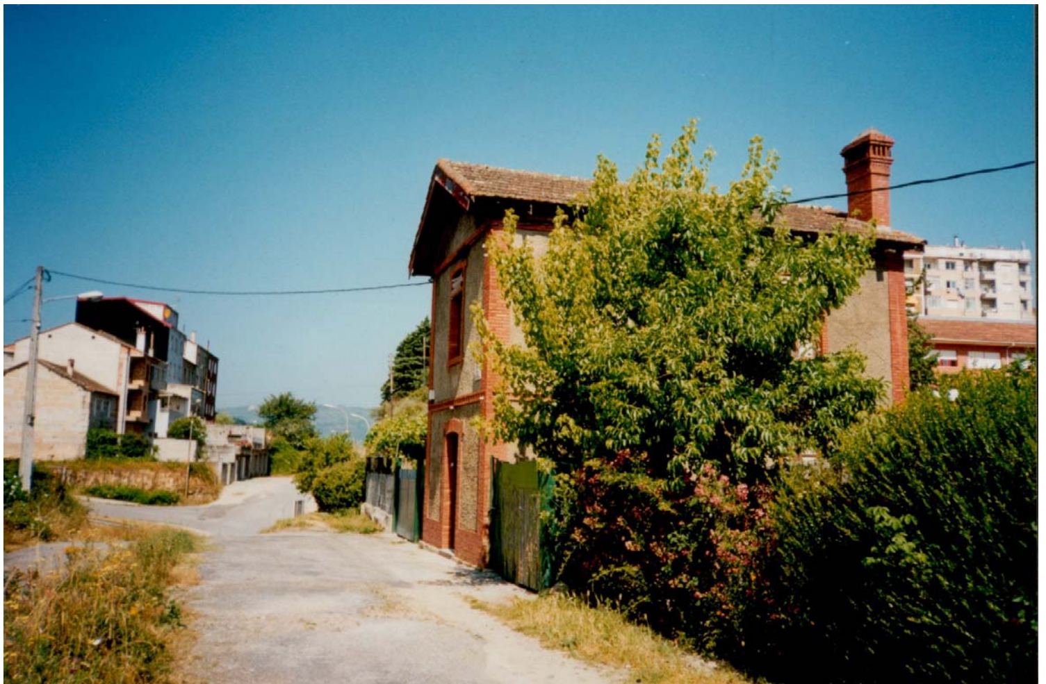
Calle "Da Casilla", con el trazado de la antigua línea a Vigo. Podemos ver la casilla de guardavías que dio nombre a la calle, hoy derruida para la construcción de la nueva sede de la policía local
