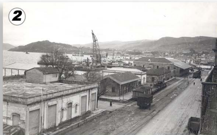
Avenida Montero Rios con los distintos almacenes de carga.
