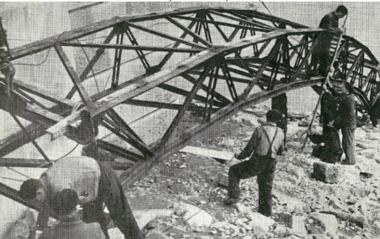
2 Colocación de los primeros trozos (cuchillos) en un apoyo del lado Zamora (foto AA)
