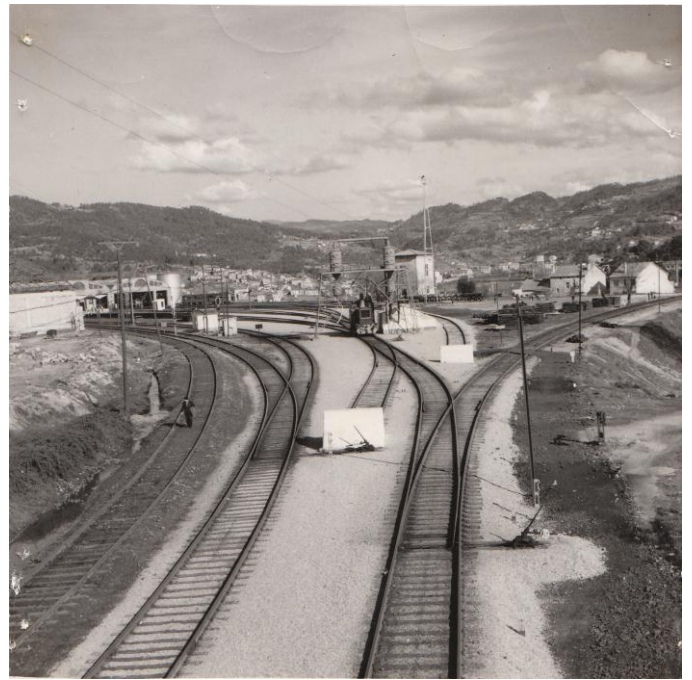
Imagen superior: Salida de la estación Empalme lado Zamora y Monforte. La vía de Zamora es la que se encuentra a la derecha, el desvío da servicio a la vía de acceso al depósito. El viaducto tiene su inicio justo al final de la curva a la derecha de la foto (Foto AA)
