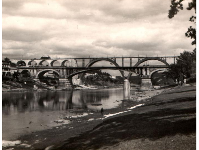
Imagen superior: Vista del viaducto en fase de encofrado (foto AA)
