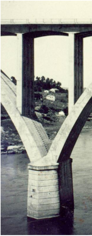
Imágenes superiores: Tres imágenes de detalles constructivos del viaducto, uno de los apoyos centrales, pilastra y estribo con uno de los arcos del tramo de acceso y estribo del viaducto en el lado Coruña (fotos AA)
