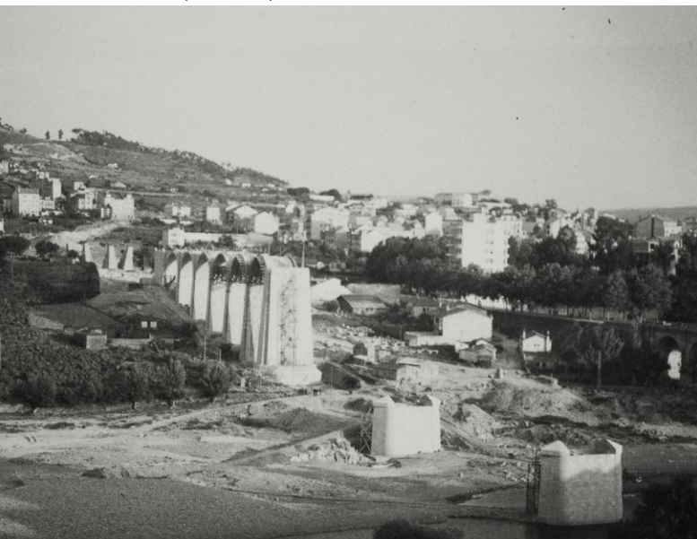
Imagen inferior: Vista de la construcción del lazo Zamora y de los apoyos de los arcos centrales (foto MAPO)
