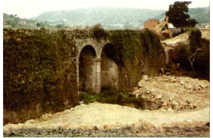
Imagen superior: Puente de As Caldas ya fuera de servicio a finales de la década de los 80 del pasado siglo.
