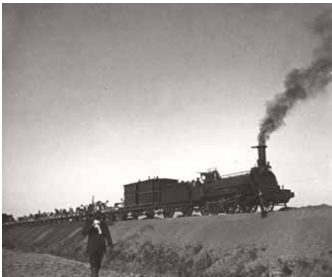
Tren de obras y mantenimiento en la línea de Medina del Campo a Zamora. Hacia 1906. Fotógrafo Federico Cantero Villamil. Fotografía cedida por Federico Cantero Núñez.
