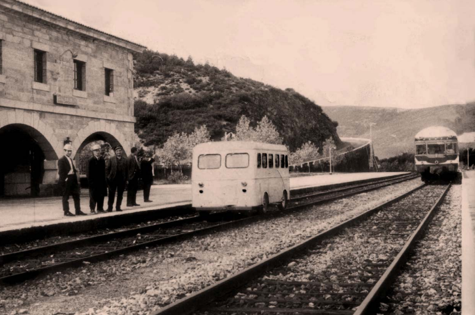
Un grupo de ingenieros en la estación de Campobeceros esperando el cruce de su vehículo de inspección de vía, con el recién estrenado TER
