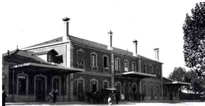
Edificio de viajeros de la estación de Ourense (1885-1952), Foto Museo Arqueológico Provincial
