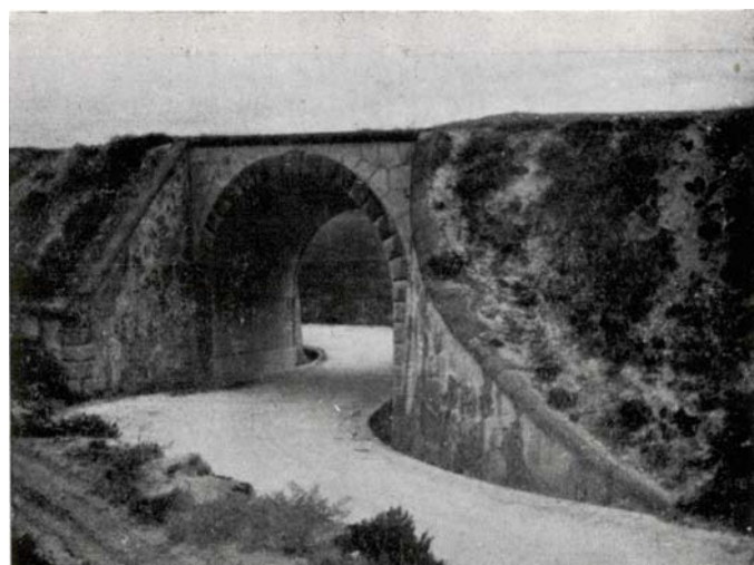
Arriba: Seixalbo, Ourense, ejemplo de puente para carretera nacional.
