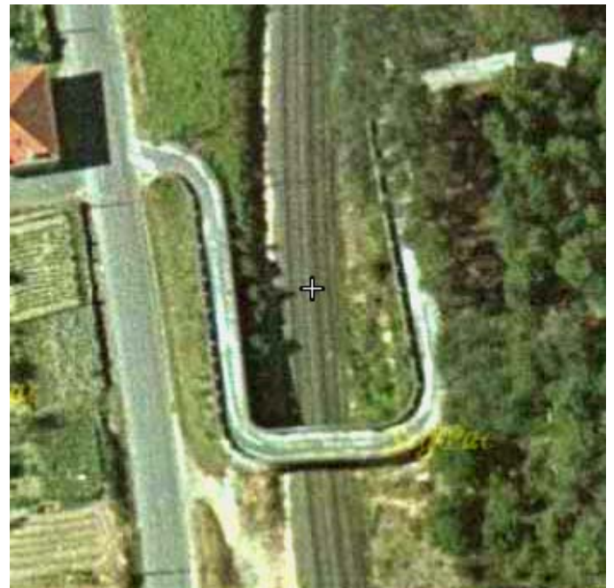
Imágenes superiores: Paso elevado entre la estación de Taboadela y el polígono de San Cibrao. Único tramo que posee vía doble en todo el trazado. Este paso es un claro ejemplo da tipología en U. (Foto SIGPAC)
