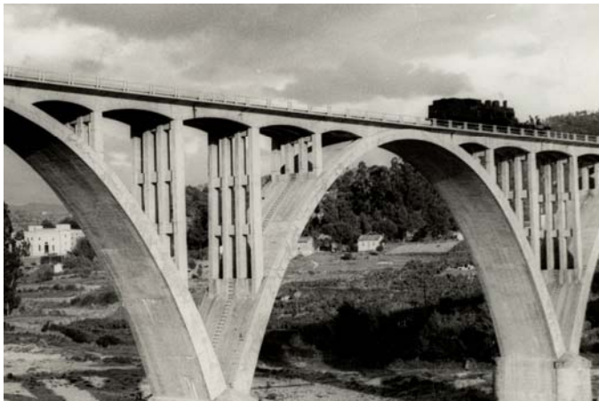
Tímpanos aligerados característicos del viaducto Miño 1957 (Foto Julio García).
