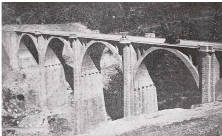
Distintas imágenes del proceso constructivo del viaducto.
