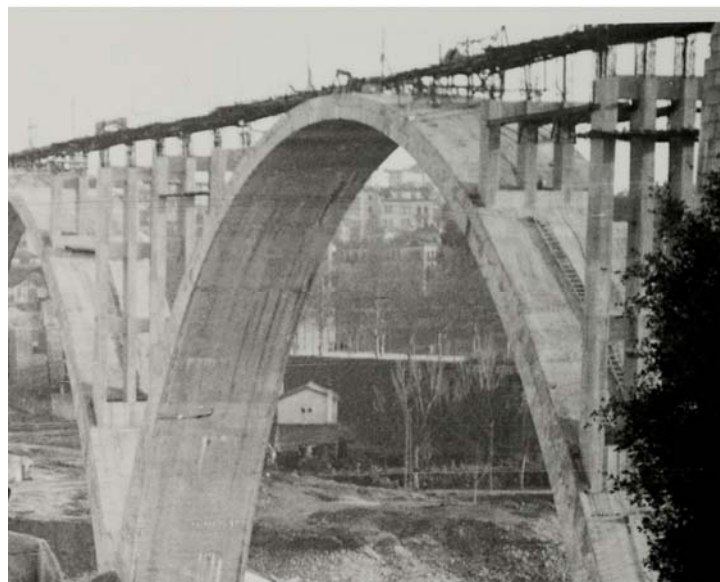
Dos imágenes de las distintas fases de construcción del Viaducto Miño. A la izquierda inicio de los trabajos de colocación de las cerchas rígidas de los arcos centrales. A la derecha, construcción de los caballetes de los tímpanos aligerados (Foto Julio García).
