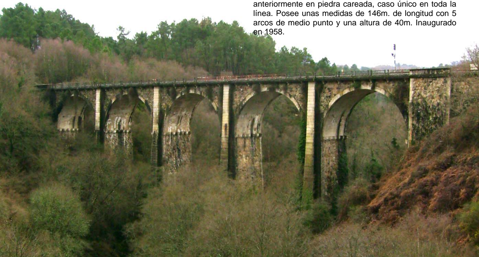
Imagen actual del viaducto (enero de 2008)
