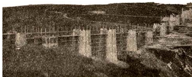
Vista de la construcción del viaducto de Truchas en el año 1930.
