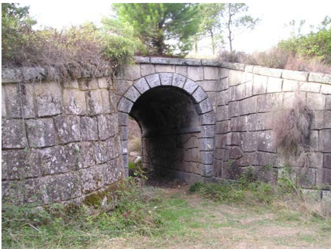
Imágenes inferiores: Dos pasos inferiores, el de la izquierda situado en Rairo, Ourense, con una luz de 3m. y una altura de 3,60m., para salvar un camino vecinal, y el de la derecha en Riofrío, Zamora, para salvar un regato. Este último con una estética que se sale del esquema normalizado aplicado en el resto de este tipo de obras.
