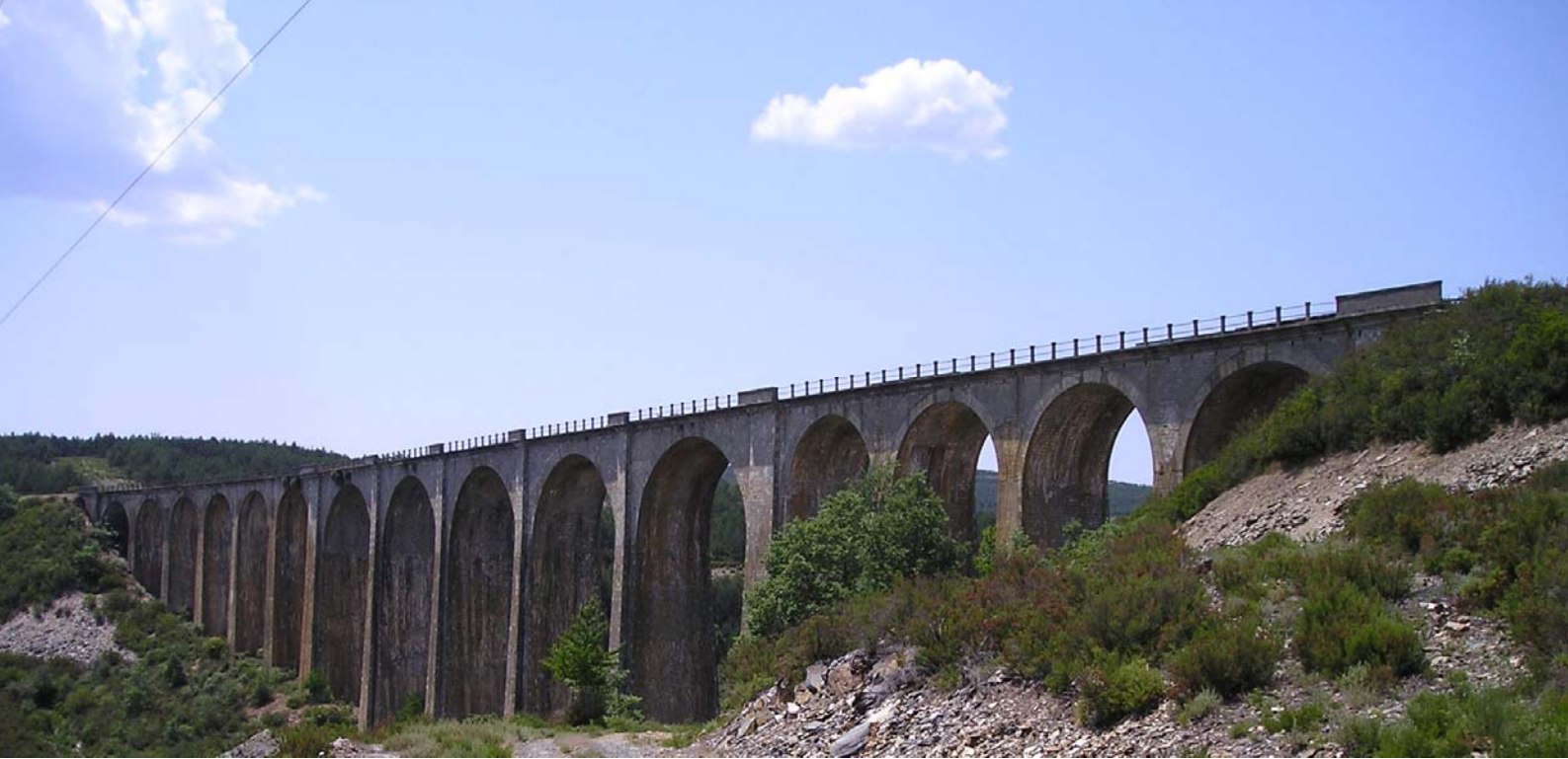
Imagen actual del viaducto de Truchas.
