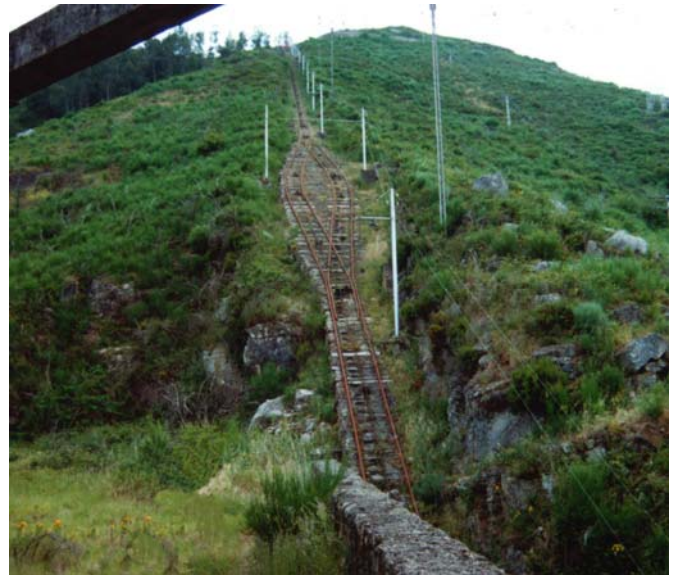
Enriba: Desvíos para o cruce das cabinas e os postes da catenaria (1992).
