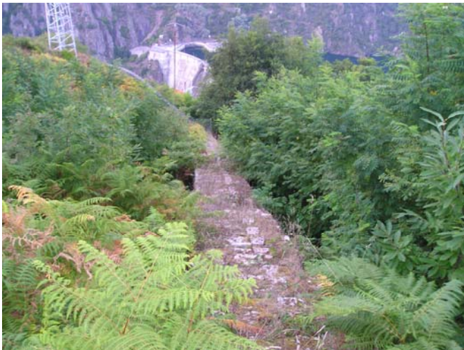
Enriba: Plataforma da vía en talude ao saír da estación de A Rasa (2006)
