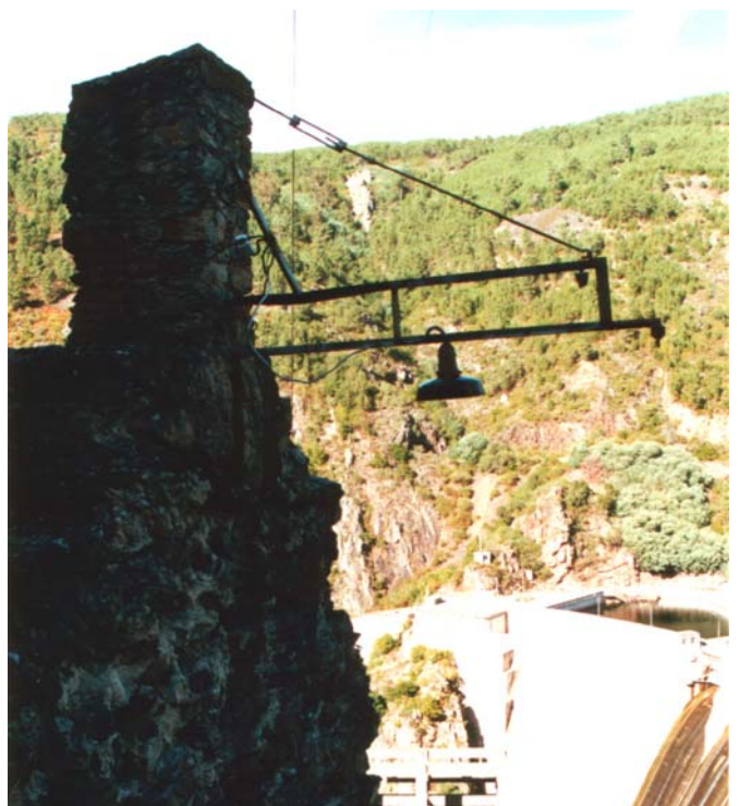
Enriba: Ménsula e poste para catenaria feito de cachotería (1999).
