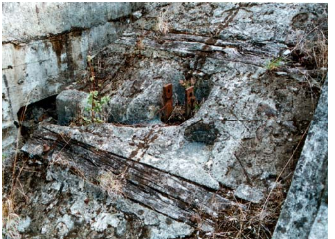
Abaixo: Travesas embutidas e resto da suxeición da polea (1999).
